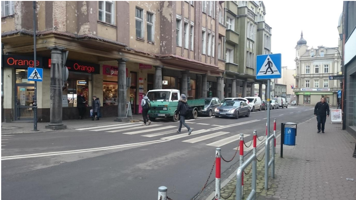
Nawierzchnia: asfaltowa, betonowa kostka brukowa. Krawężnik: granitowy.
