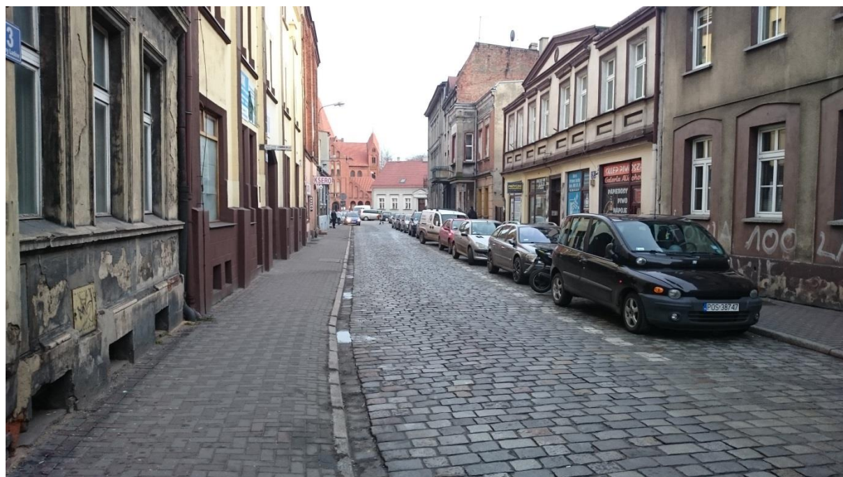
Nawierzchnia: granitowa kostka brukowa, betonowa kostka brukowa. Krawężnik: granitowy.
