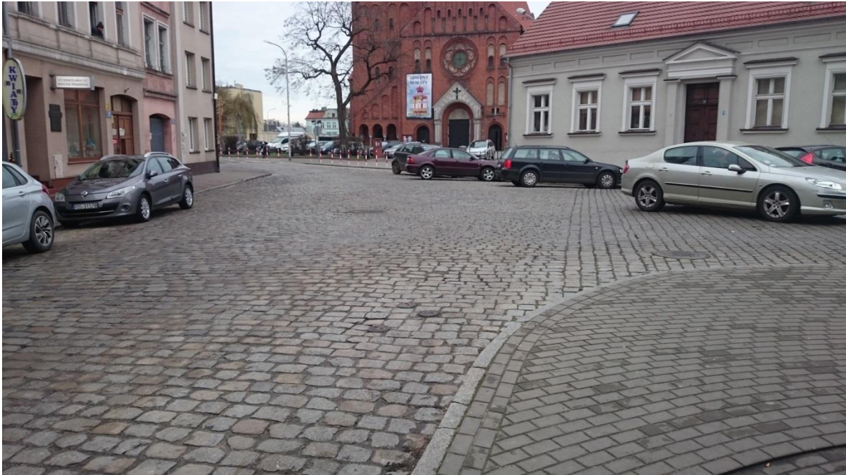
Nawierzchnia: granitowa kostka brukowa, betonowa kostka brukowa. Krawężnik: granitowy.
