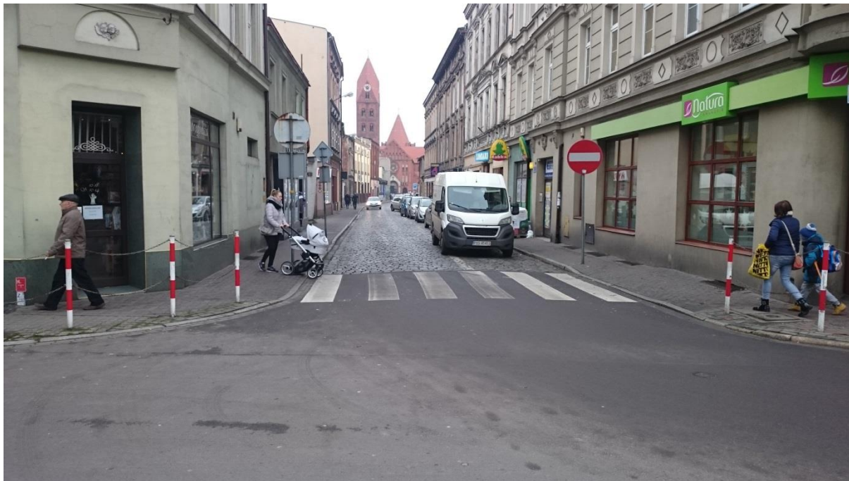
Nawierzchnia: asfaltowa, granitowa kostka brukowa, betonowa kostka brukowa. Krawężnik: granitowy.
